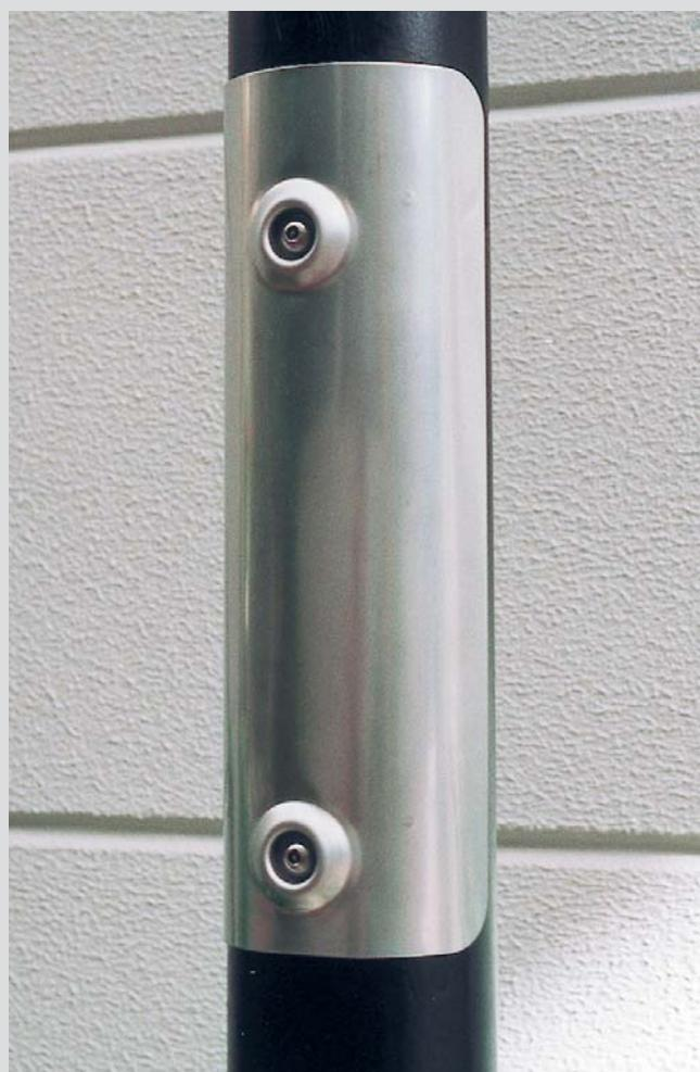
Eingeschweißte Edelstahlwinkelbleche, zwei eingebrachte Napfzüge, verstärkte Befestigungsprofile sowie Sicherheitschrauben garantieren Haltbarkeit auch bei extremen Belastungen.
